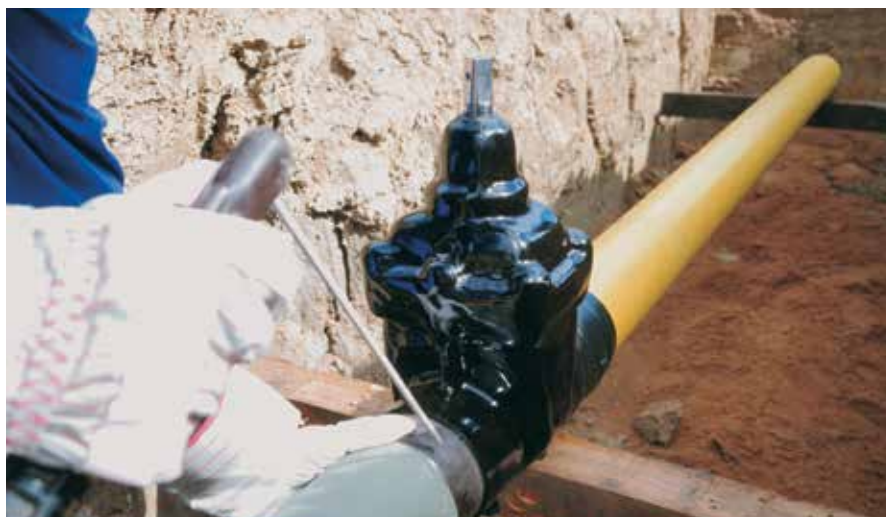
Задвижка с продувочными отводами
